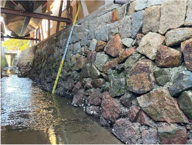
古江川修繕工事
