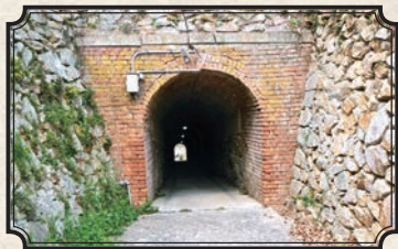
上組トンネル入口（上組区側）
