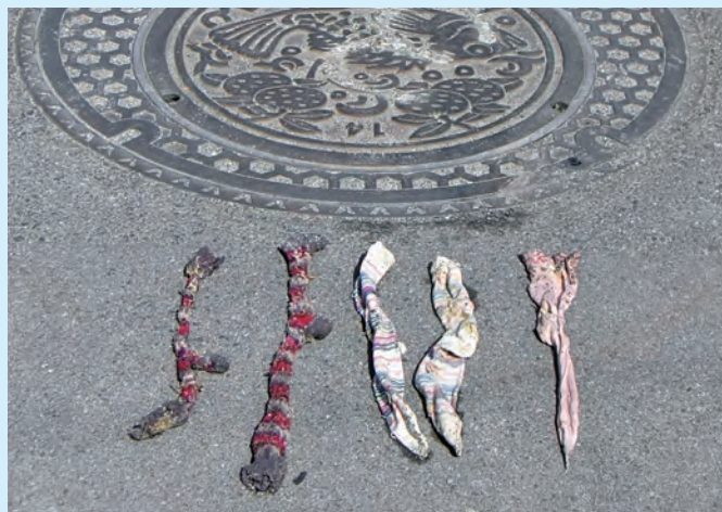
ポンプに詰まっていたくつ下
