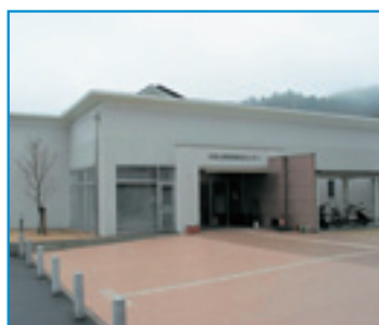
太陽電池を設置
