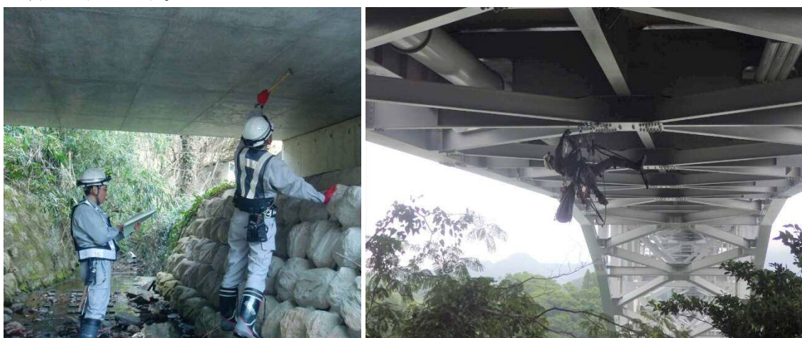
橋梁定期点検状況
