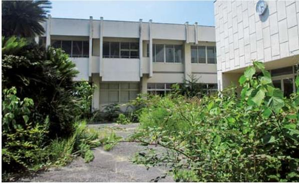
ンクリートを破壊検査したところ、耐震基準を満たしていない結果があった。
