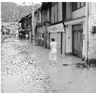
木江地区の高潮被害
