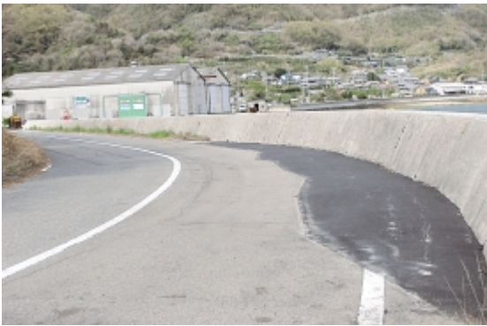
ストックヤードへの道路
