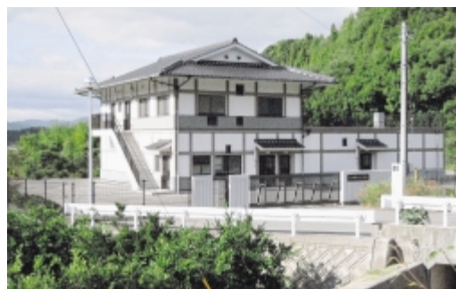
大串浄化センター
