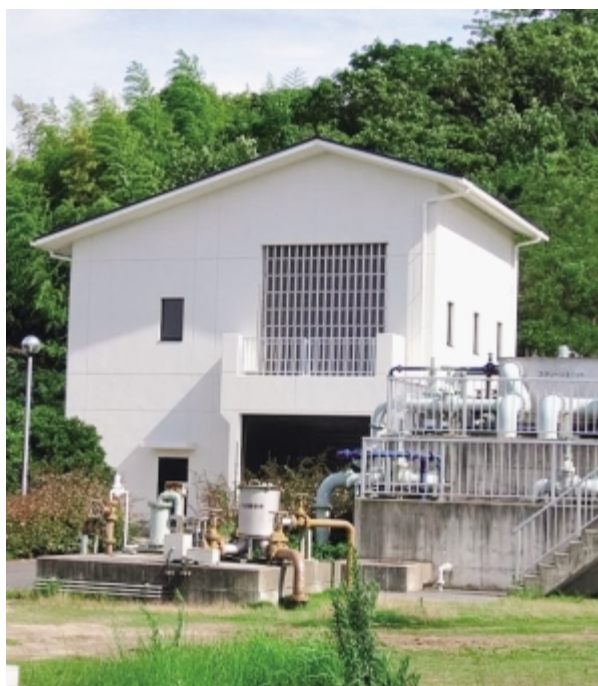
大崎浄化センター
