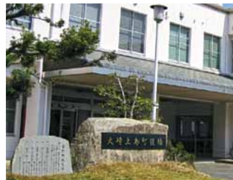
大崎上島町役場本庁舎
