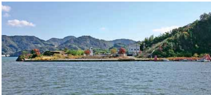
原下物揚場（対岸から）
