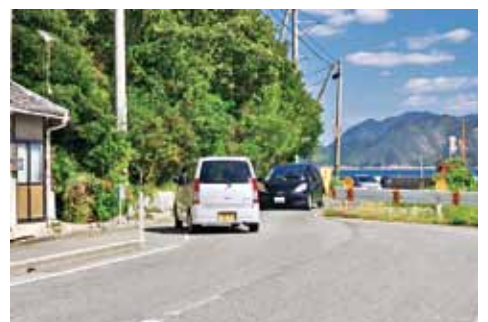
離合の困難な未改修道路
