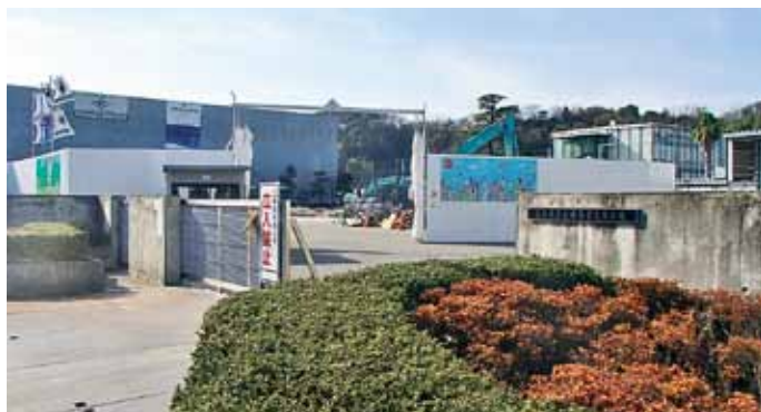
校舎改修中の大崎海星高等学校
