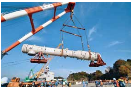
搬入中の石炭ガス化炉
