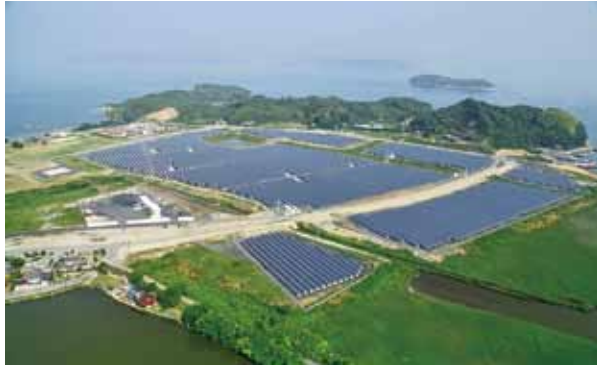
太陽光発電所
