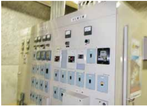
木江支所非常用発電機
