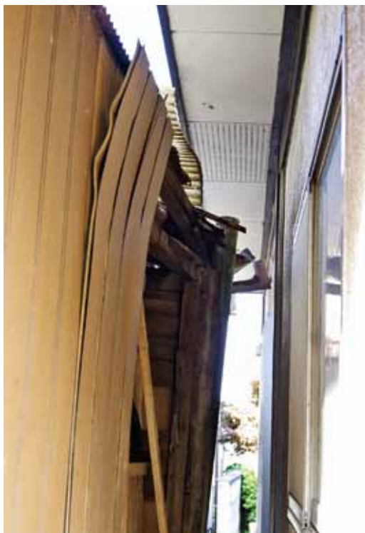
隣家に倒れかかる空き家
