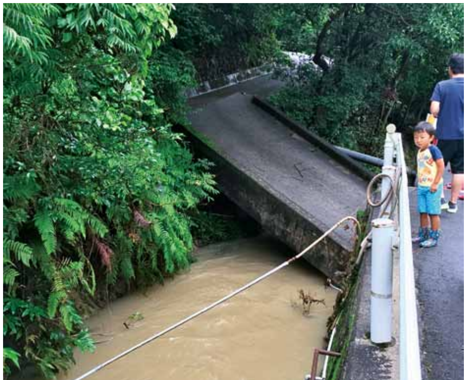
崩落した原田地区の橋
