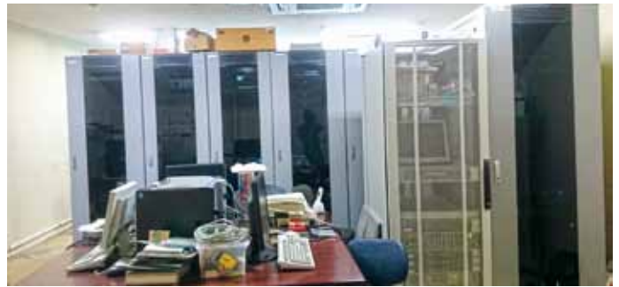
会議室がサーバー室。設備の整った専用室も必要です。
