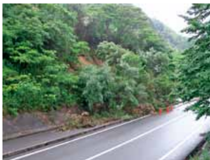
土砂崩れの町道
