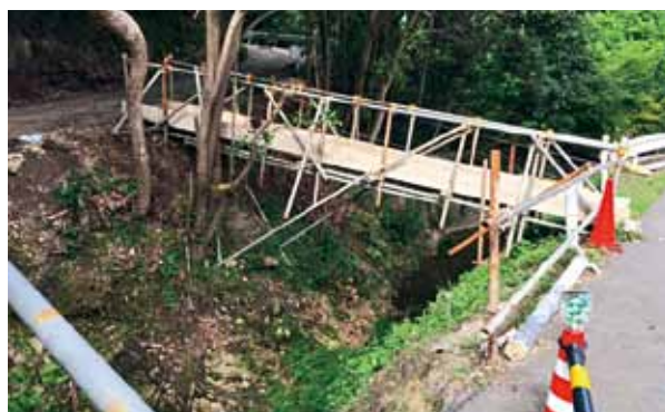
原田の仮設橋
