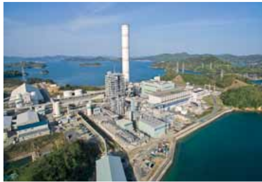
酸素吹1GCC実証試験発電所(中国電力(株)大崎発電所構内) 大崎クールジエン(株)提供
