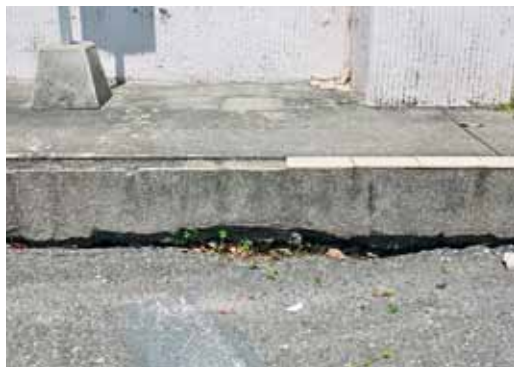
本庁舎駐車場の陥没部分
