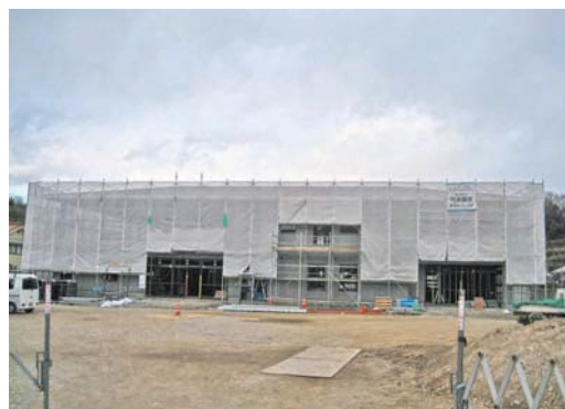
建設中の学習交流センター
