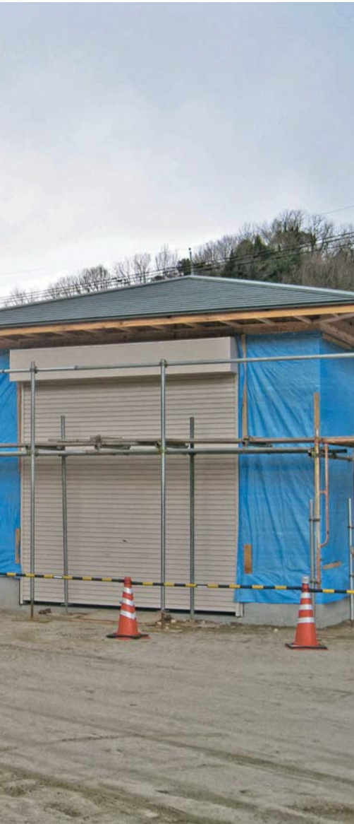
現在建設中の処理施設
