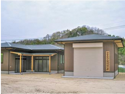
完成した処理施設
