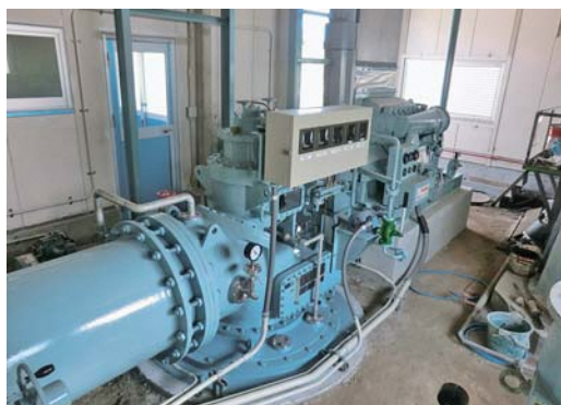
前年度完成の西野ポンプ場
