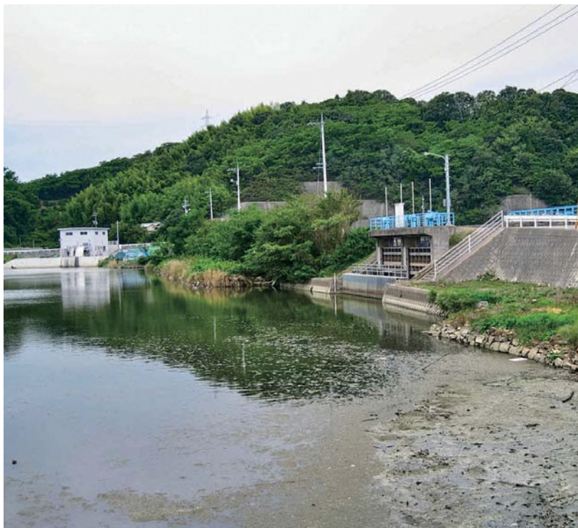
中野新開の樋門及びポンプ所
