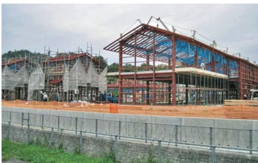
建設が進む住宅
