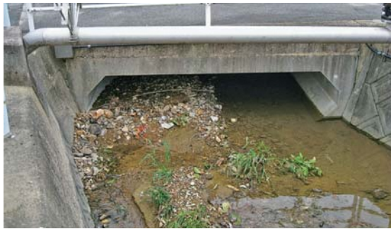
堆積した土砂
