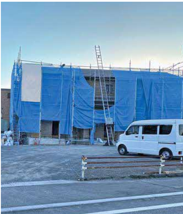
町外業者で建設中
